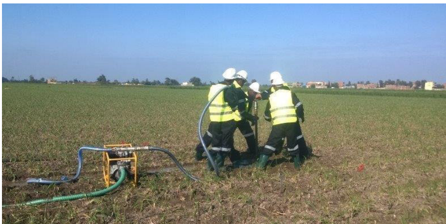
Wiercenia flushing jet sprawdzają się na obszarze Deltę Nilu
