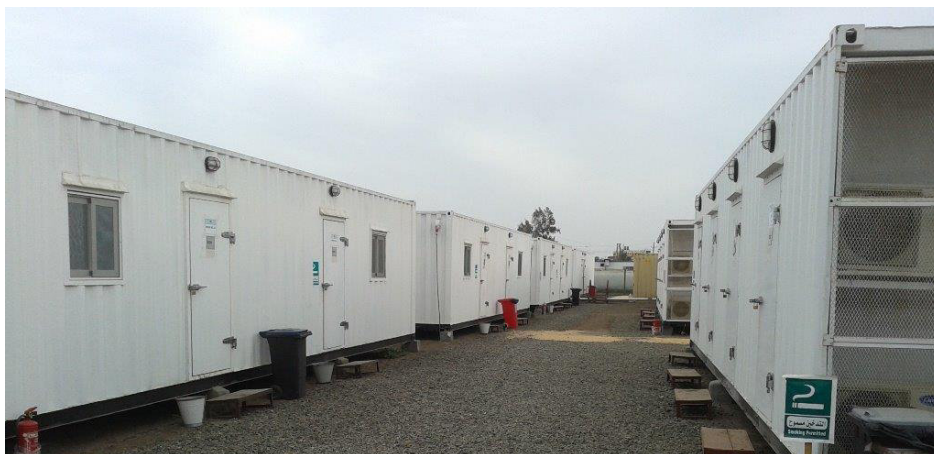
„Kontenerowa” część kampu
