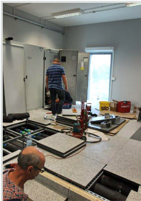
Montaż podłogi technicznej i podłączanie szaf klimatyzacji precyzyjnej (z lewej) oraz UPS-ów w rozdzielni
