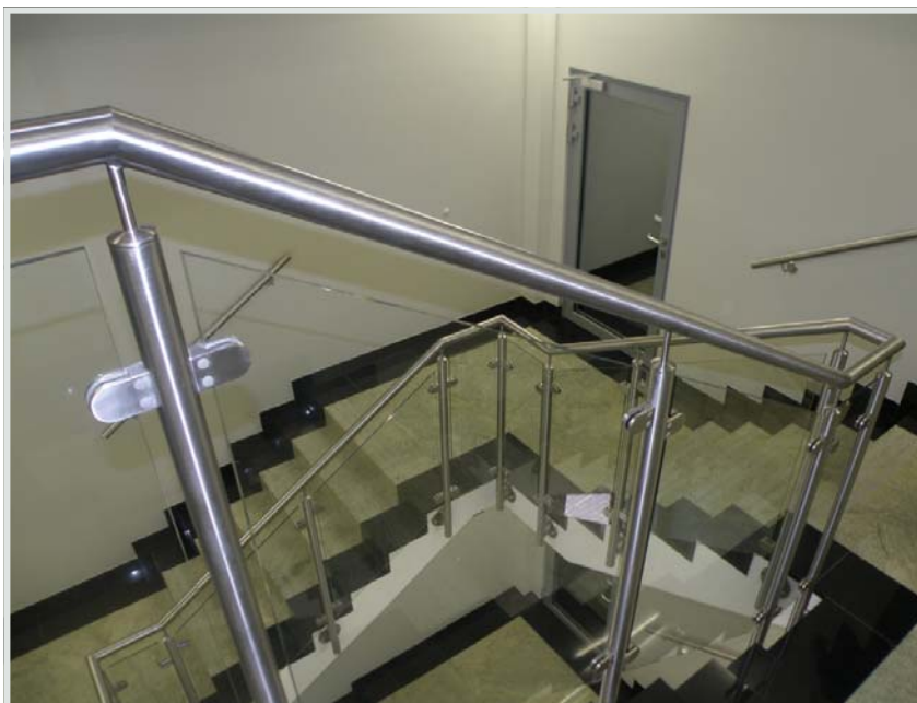
Klatka schodowa - znów granit i metalowe, sterylne poręcze
