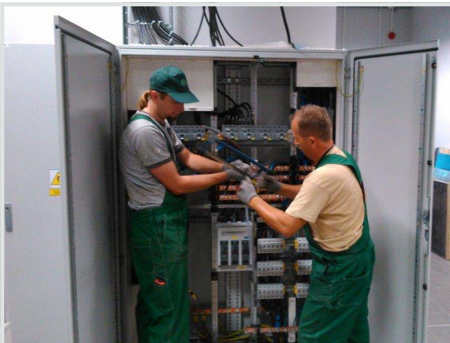
Montaż podłogi technicznej i podłączanie szaf klimatyzacji precyzyjnej (z lewej) oraz UPS-ów w rozdzielni
