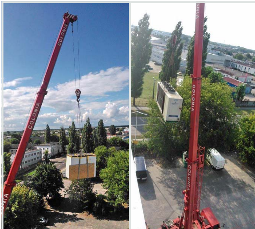
Transport szafy klimatyzacyjnej i agregatu wody lodowej na taras Łącznika
