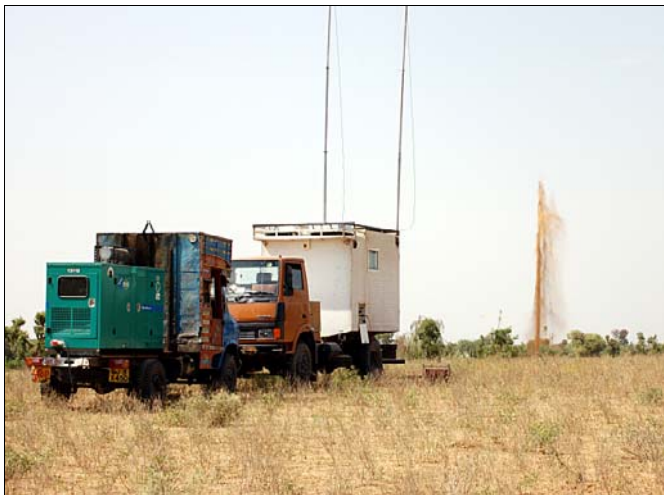
Prace w Gujaracie
