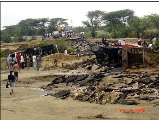
Tak żywioł wody poradził sobie z asfaltem
