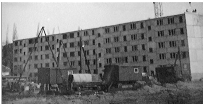
Biurowiec w budowie
