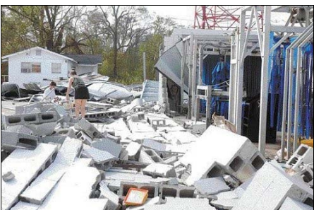
Zniszczenia we wschodnim Teksasie
