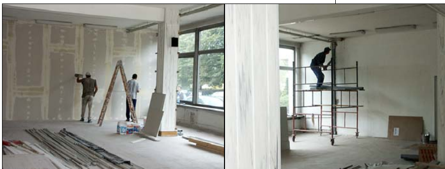
Remont świetlicy trwa
